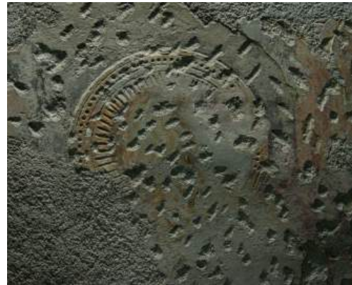
Fig.40. Punzanatura on a relief plaster layer
