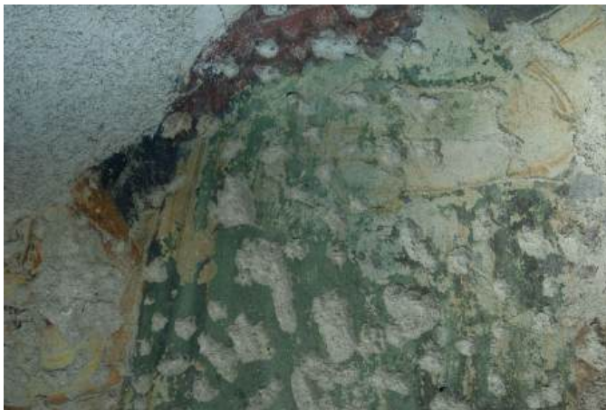
Fig.67. Abrasione of the pictorial layer
